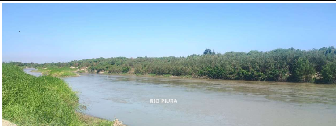
FIGURA N°01: TRAMO CRÍTICO EN EL RIO PIURA, EN SECTOR NUEVO CASARANA - MOCARA, DISTRITO DE LA ARENA, PROVINCIA DE PIURA - PIURA.
